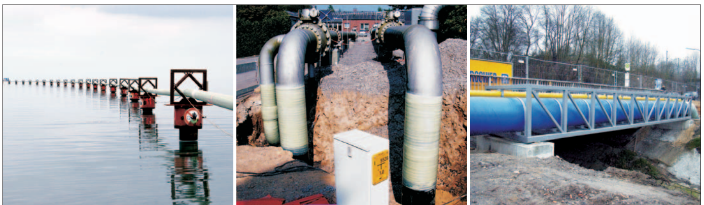
Bild 1: Leitungen zur Erdölplattform Mittelplate, Schweißnahtumhüllung Kebudur HT-80-System (links), GFK-Umhüllung Boden-/Luftbereich in einer Verdichterstation (Mitte), GFK-Umhüllung einer Brückenleitung (rechts)
