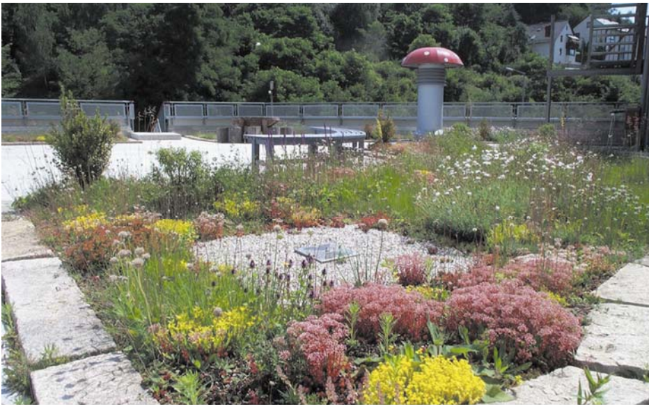
Ein Stück Natur auf dem Flachdach mit Kebu-Schweißbahnen
