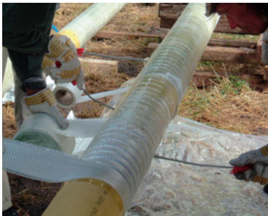
Abb. 3 Baustellenapplikation von Vinylesterharz, Glasgewebe und Abschlussvlies
