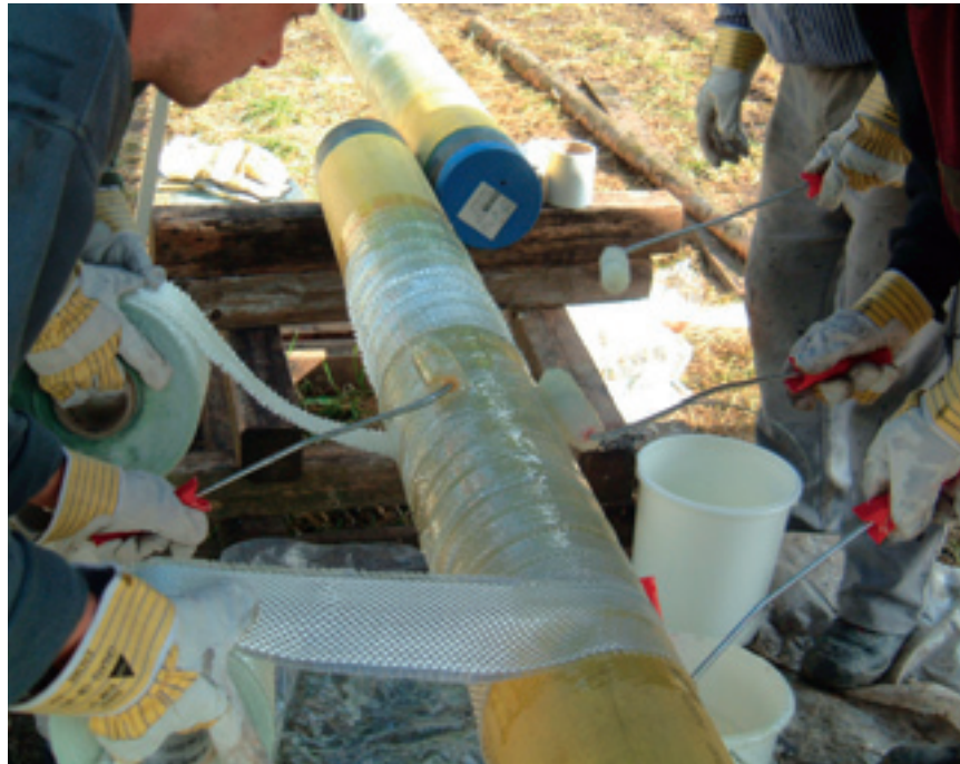
Abb. 2 Verarbeitung von Vinylesterharz und Glasgewebe als GFK-Verstärkung
