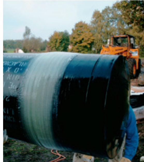
Abb. 6 GFK-Abstandshalter für das Rohrin-Rohr-Einzugsverfahren
