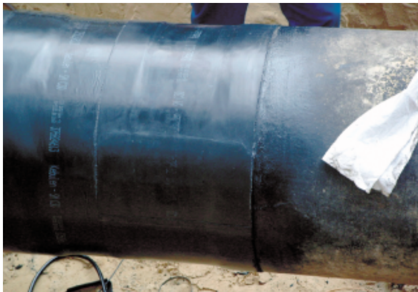
Bild 2 ■ Applikation von Schrumpfmanschetten auf eine in Betrieb befindliche Wasserleitung.
