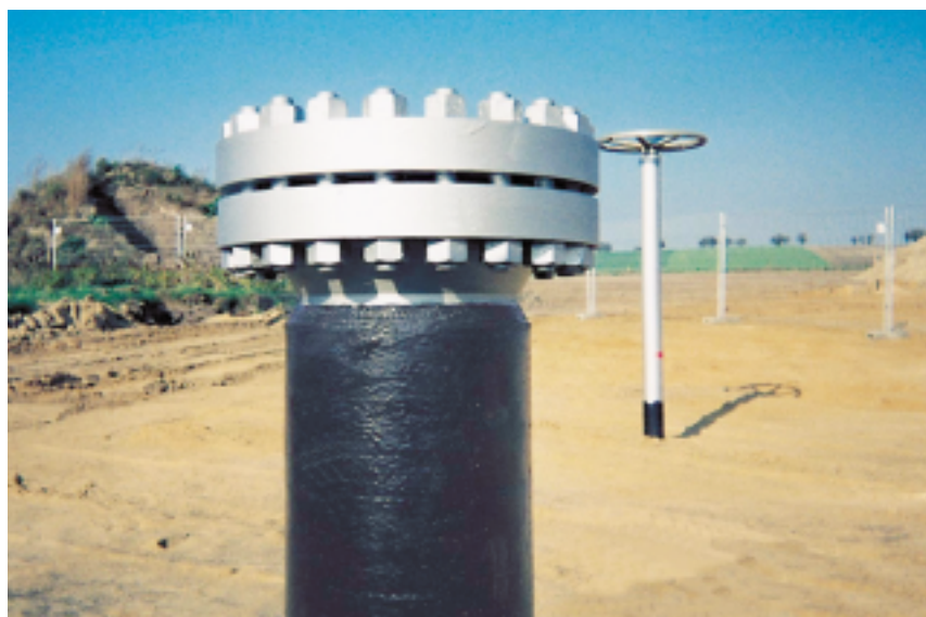
Bild 1 ■ Boden-Luft-Übergang mit kunststoffmodifizierten Bitumenbändern.
