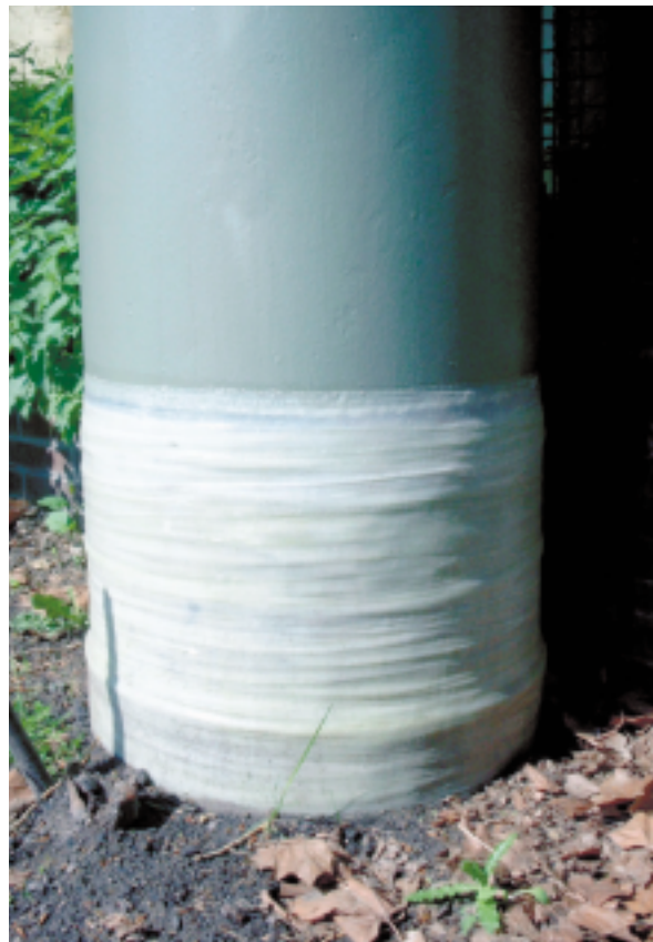
Bild 3 ■ Kebudur UP-System im Übergangsbereich Boden/Luft.
