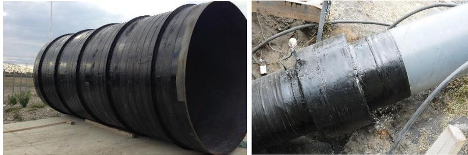
**Kebu Bitumen-Band GW/HT** ist ein warmverarbeitbares Korrosionsschutzband nach Din EN 10300 Abschnitt 4.2.7 (vormals DIN 30673), Belastungsklasse B bei einer maximalen Dauerbetriebstemperatur von 40 °C.
