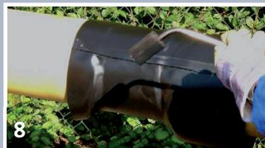
8 Ausgehend von der Mitte (Schweißnaht) in Umfangsrichtung zur einen Seite schrumpfen.
