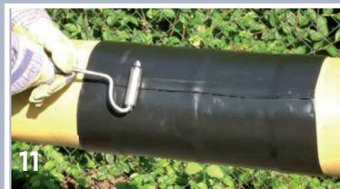
11 Den Übergang zur Werksumhüllung, den Schweißnahtbereich der Rohrleitung und den Schweißnahtbereich des Schrumpfschlauches andrücken.
