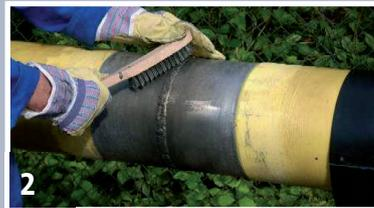
2 Oberfläche durch geeignetes Verfahren (z.B. Strahlen, Handdrahtbürste, Schmirgelleinen) gemäß GW 15 reinigen.
