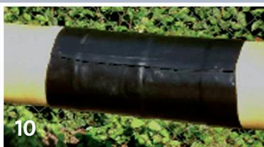
10 Der Schrumpfvorgang ist beendet, wenn der Schrumpfschlauch überall eng anliegt.
