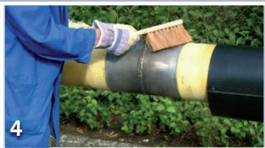
4 Staubreste vorzugsweise durch Abblasen entfernen oder mit einem Besen abfegen.
