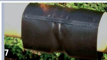
7 Mit einer weich eingestellten Propan- gasflamme unter gleichmäßiger Bewegung in Umfangsrichtung in der Mitte oben beginnend schrumpfen.
