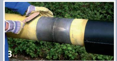
3 Je 100 mm der Werksumhüllung in die Reinigung mit einbeziehen. Diese Fläche mit einer Drahtbürste in Umfangsrichtung aufräumen.
