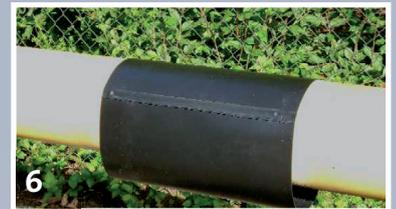
6 Den **Kebulen-Schrumpfschlauch C50** so anlegen, dass seine Klebestelle in 2 bzw. 10 Uhr Position liegt.
