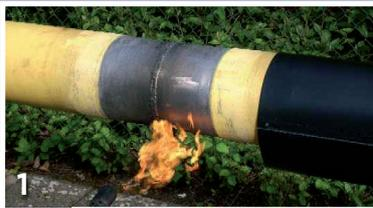
1 Den **Kebulen-Schrumpfschlauch C 50** einschließlich der Schutzfolie vor dem Herstellen der Schweißverbindung auf das Rohr schieben.
