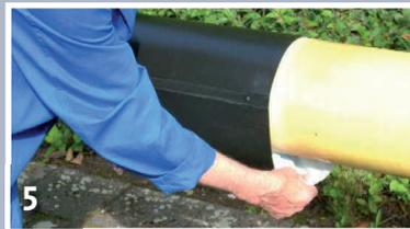
5 Den **Kebulen-Schrumpfschlauch C 50** mittig über die Schweißverbindung positionieren. Die Schutzfolie seitlich herausziehen.
