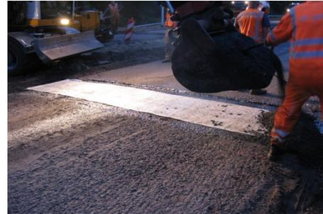
Die **Corabit Armierungsbahn** ist eine selbstklebende Polymerbitumenbahn mit rissüberbrückenden Eigenschaften. Sie ist geeignet zur Bewehrung, Spannungsentlastung und als Barriere (R+STR+B) beim Bau von Fahrbahndecken und Asphaltsschichten. Die **Corabit Armierungsbahn** ist auch als SAMI-Schicht (stress absorbing membrane interlayer) einsetzbar. Die Dicke beträgt ca. 2,5 mm bei einem Flächengewicht von ca. 2,5 kg/m<sup>2</sup>.
