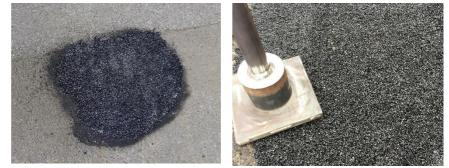
Corabit REP lässt sich leicht und problemlos im Handeinbau verarbeiten. Die Unterlage muss tragfähig und sauber sein, der Untergrund darf feucht sein. Corabit REP etwas erhöht einbauen und mit einem Handstampfer oder einer Schaufel verdichten und leicht abstreuen. Die Einbaudicke beträgt circa 2 cm. Bei Ausbesserungen unter 1 cm Dicke sowie bei Betonunterlagen sollte zur Haftverbesserung der Corabit FB Voranstrich verwendet werden.
