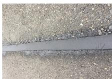
den Das Corabit Rissband KK bildet im Zusammenwirken mit dem Corabit des, VG Voranstrich eine sichere Abdeckung von Rissen und offenen Fugen im Straßenbau. Es ermöglicht somit eine kostengünstige und schnelle hen Sanierung von Asphaltoberflächen.
